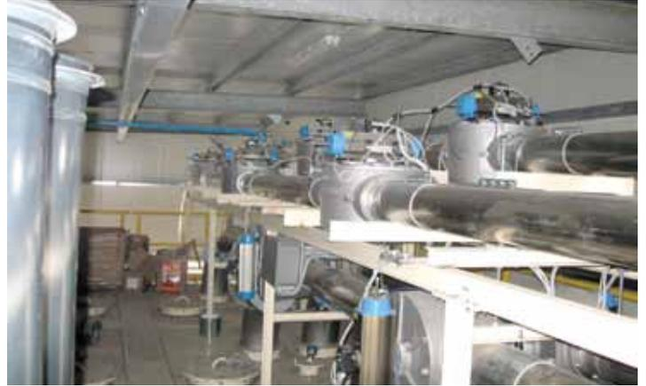
VAR Trommelrohrweichen sind wichtige Komponenten pneumatischer Fördersysteme zur Umleitung des Förderstroms.
